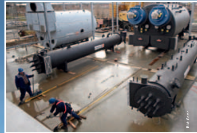
Einbau der Kesselanlagen bei Radici
